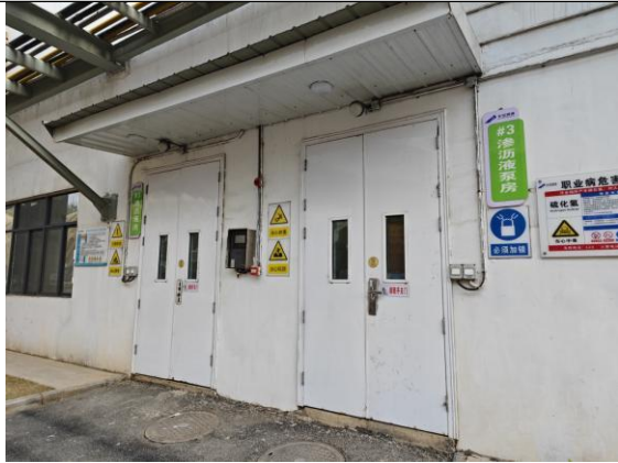
渗滤液处理站
