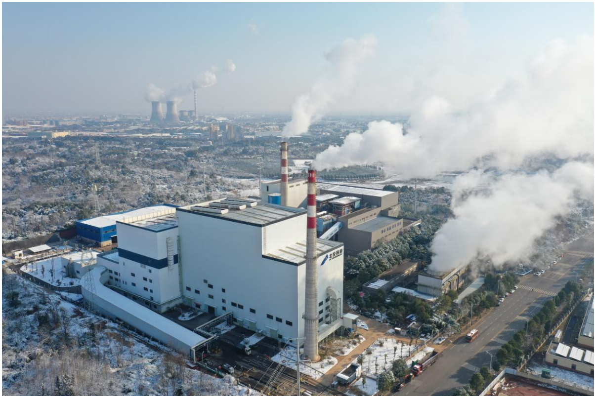
图 3.1-1 现有焚烧厂厂区全貌图
