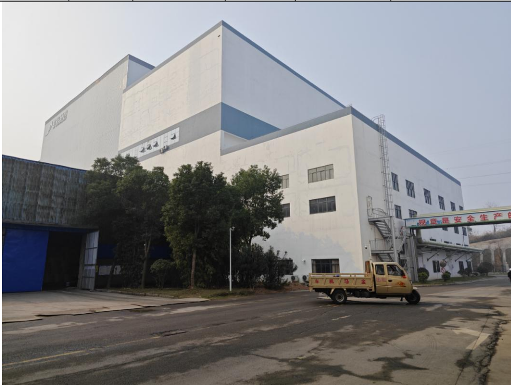
图 3.6-6 现有工程噪声防治现场图片
